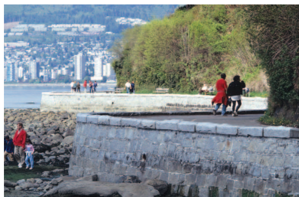
Promenade de 10km longeant le rempart de cordon littoral Parc Stanley – LHN du Canada
