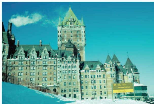
Hôtel de style Château avec symétrie de l'Éclectisme Pittoresque construit de 1892 à 1893 Château Frontenac – LHN du Canada © Parcs Canada PHOTO : Bouliane, M.
